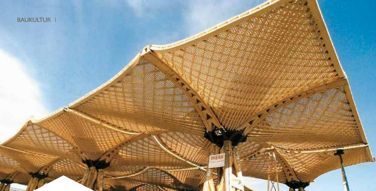
Das Dach für die Expo 2000 in Hannover wurde aus Weißtannenholz gebaut, es ist das größte freitragende Holzdach der Welt
